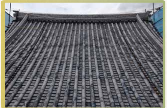
本堂屋根施工前。約40年に亘って雨風に耐えていただきました。
